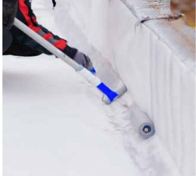
MB PUReactive TX ist in zweifacher Hinsicht optimiert. Zum einen für vlies-armierte Detaillösungen, wo es sich dank seiner thixotropen Einstellung hervorragend an Durchdringungen und aufgehende Bauteile anarbeiten lässt. Dazu gehören bodentiefe Fenster über Flachdächern, Balkonen, Loggien und Laubengängen ebenso wie Sockel- und Putzabdichtungen. Zum anderen für gespritzte Flächenabdichtungen.
